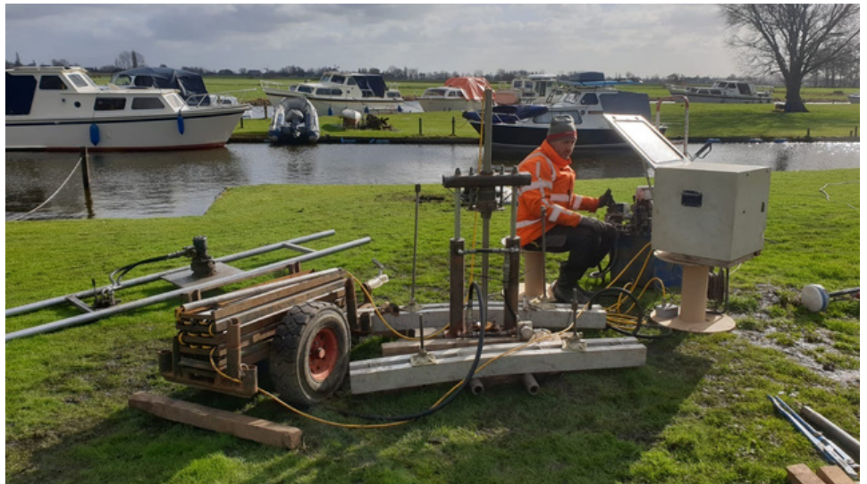
Grondframe met betonankers
